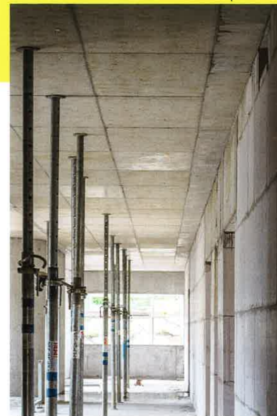
Die Rohbauarbeiten fanden im Frühsommer 2023 statt.
