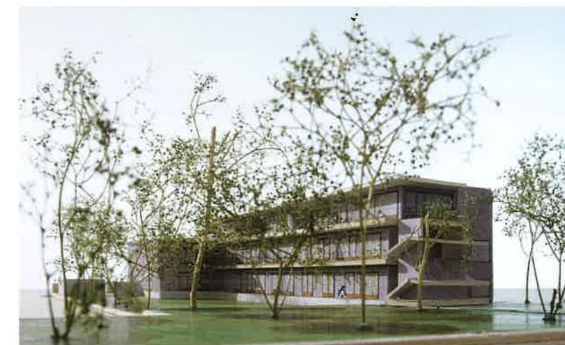
Auf den beiden massiven Etagen der Kita sind sechs Wohnungen in Holzbauweise aufgesattelt.
